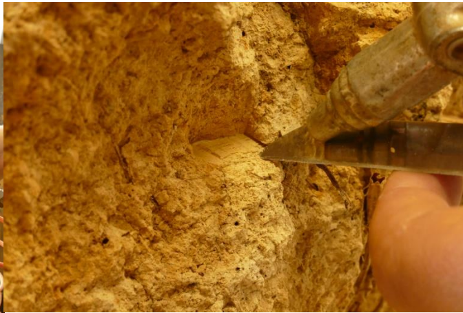
Figuur 32: Wegwerken van hardnekkige inkepingen met behulp van een mespunt en perslucht.
