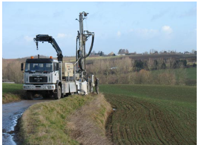
Een booropstelling die gebruikt wordt bij de aanleg van het Primair meetnet
